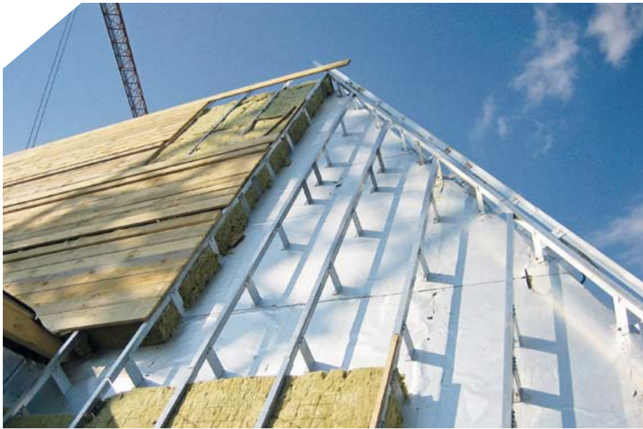
▲ Aufbau der Dachkonstruktion: Dampfsperre, Aluminium-Unterkonstruktion mit Steinwollgedämmung und abschließend imprägnierte Schalungsbretter
