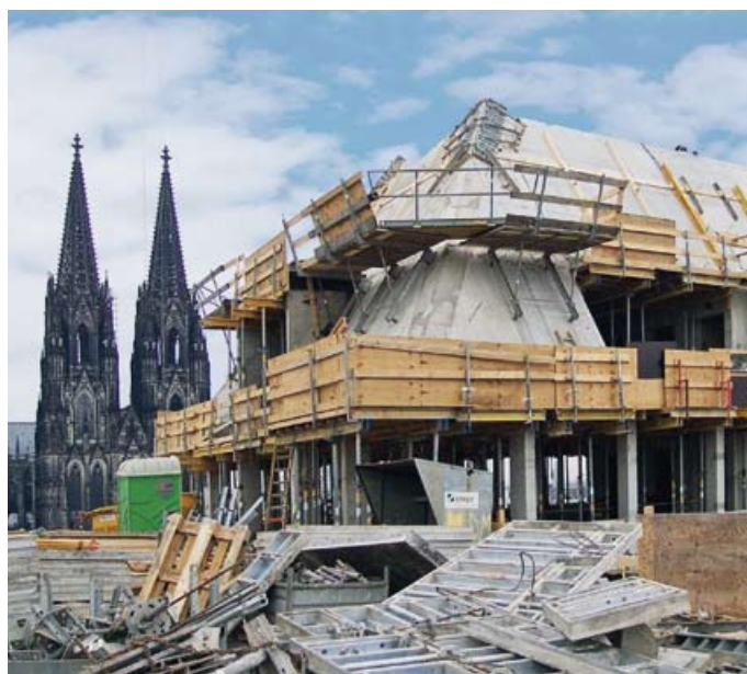
▲ Die Walmdächer wurden aufgrund der hohen Brandschutzanforderungen in Stahlbeton ausgeführt
