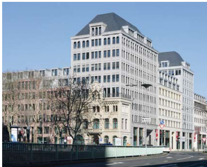
◀ Die beiden höchsten Dächer des Dominium in Köln erhielten eine Deckung aus Schiefer
