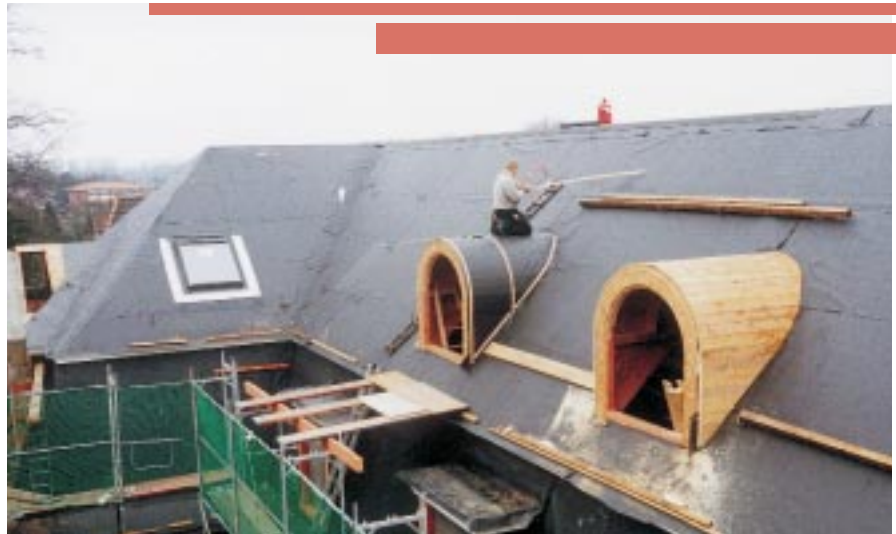
Die anthrazitfarbene Unterdeck- und Unterspannbahn Klöber „Permo ® forte“ eignet sich besonders zur Verlegung unter Schiefer.
