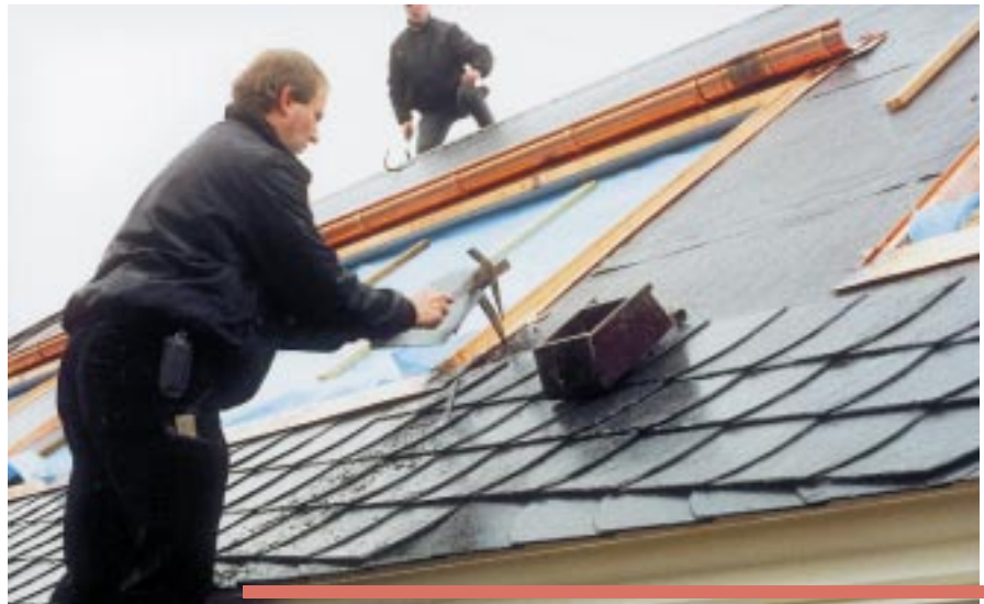
Dem Naturschiefer wird der Bogenschnitt „verpasst“.
