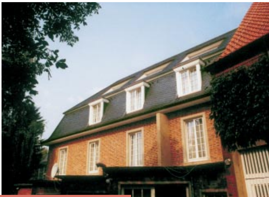
Das Dach nach Beendigung der Arbeiten.
