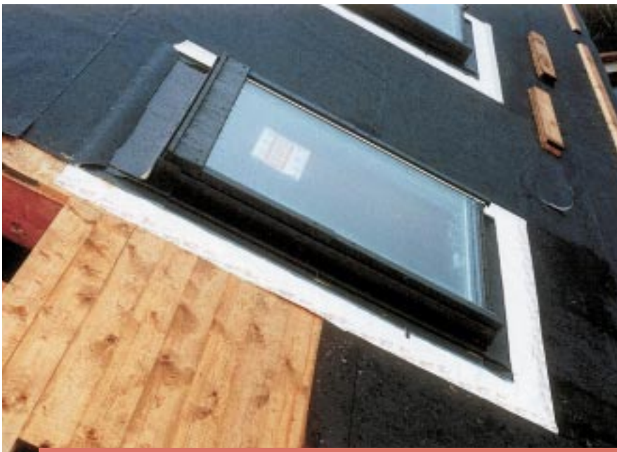
Mit den Klöber Anschlusschürzen für Wohndachfenster werden wind- und wasserdichte Anschlüsse an die Unterdeckbahn erstellt.
