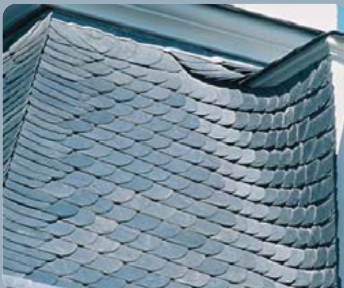
Detail einer linken ausgehenden Wangenkehle bei Linksdeckung der Mansarddachfläche. Die Kehlsteine haben runden Bruch. Die Kehlübergangsteine bewirken einen fließenden Verlauf der Kehl- und Deckgebände.
