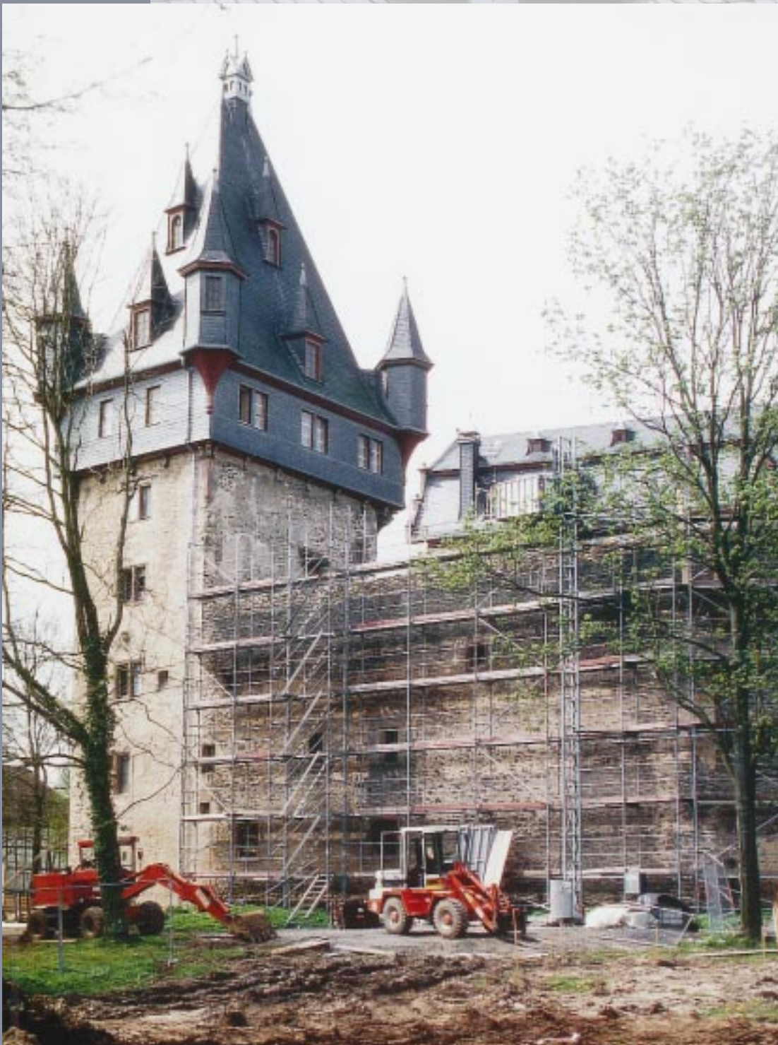
Das bei Alsfeld gelegene Schloss Romrod wird zurzeit innen und außen saniert und für eine spätere Raumnutzung mit Zielvorgaben des Denkmalschutzes ausgebaut. Das Bild zeigt den eingerüsteten Kanzleiturm.
