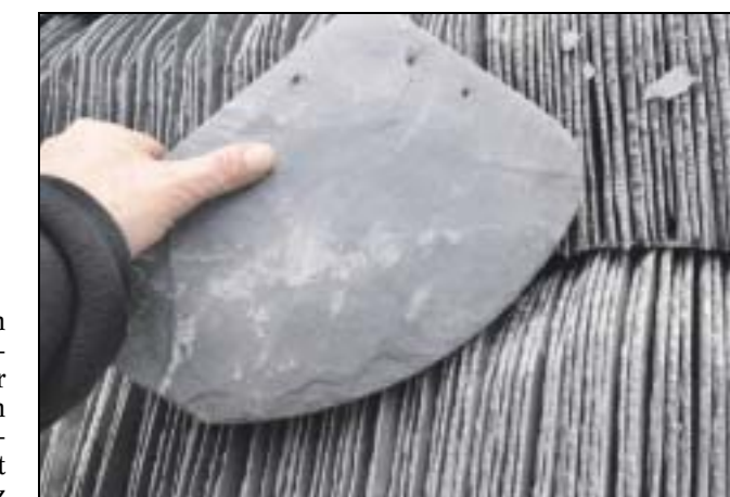
Heutzutage treffen die Schiefersteine von der Mosel vorgefertigt auf der Baustelle ein.
