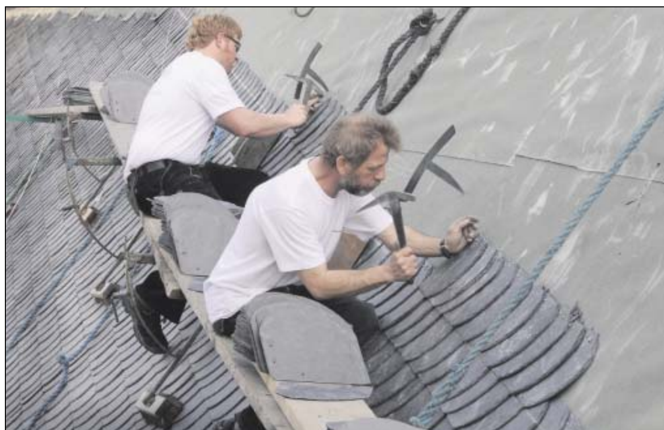
Drei, zwei eins, drin: Jeder Schieferstein wird mindestens mit drei Nägeln befestigt. Etwa 40 Steine bedecken einen Quadratmeter Dach.
